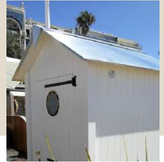
Toiture zinc Toiture bois recouverte d'une feuille de zinc (plage)
