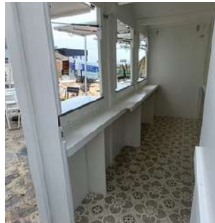
Comptoir bois Création de comptoir à l'intérieur de la cabine
